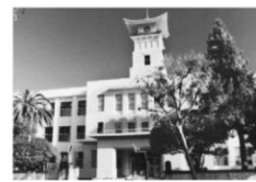
① 高知県立高知追手前高等学校 旧高知県尋常中学校在籍。創立100周年記念として寺田寅彦の銅像が建立されています。
